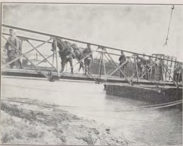
De vakwerkbruggen, die den drijvenden ponton met den wal verbonden. Een paard is juist gelost.
