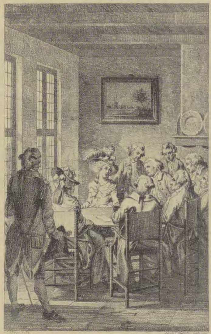
Onderhoud met hare K. HOOGHEID aan de Goefjanverwelle sluis.
